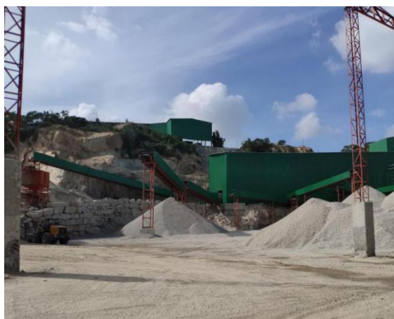
工业场地边坡治理及地面平整硬化
