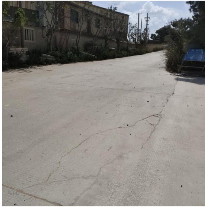
办公生活区至矿区路段地面硬化
