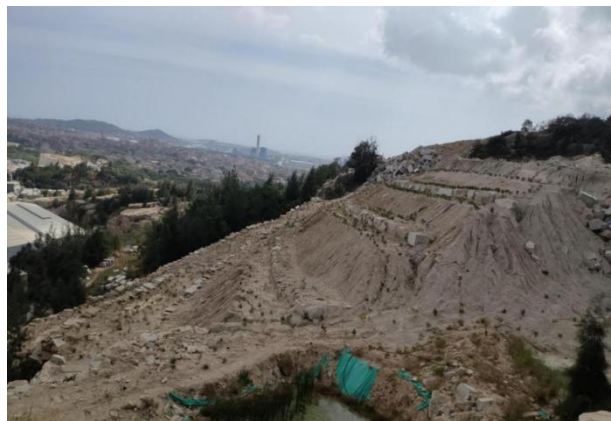
边坡防护及分台阶绿化
