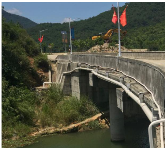
桥面径流和事故废水收集管道
